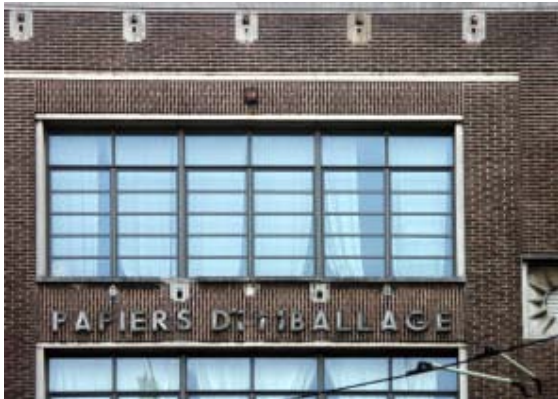
la fenêtre principale de l'atelier
