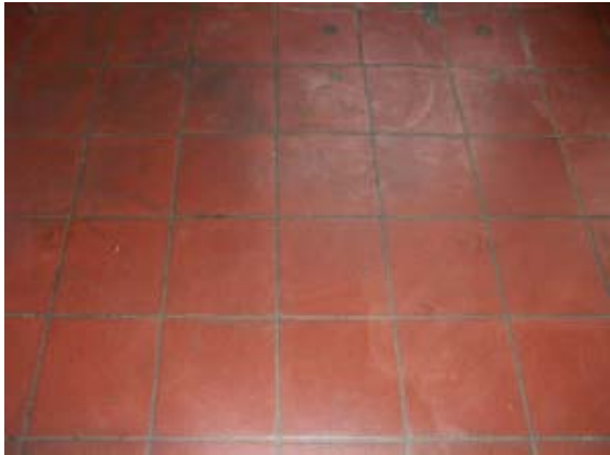
le carrelage de sol
